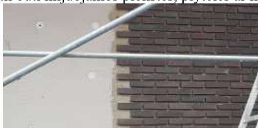
Ant šiltinamojo sluoksnio klijuojamos apdailinės plytelės.
