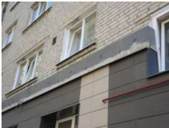
Vėdinamas ir tinkuojamas daugiabučio fasadas apšiltinamas "Kauno šilas" pilkojo putplasčio plokštėmis Šiloporas NEO EPS 70.
