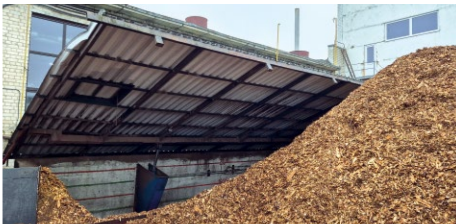
2 pav. Įgilintas biokuro sandėlis Vilkaviškio katilinėje
