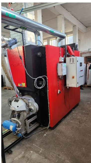
3 pav. Naujasis 300 kW galios katilas.
