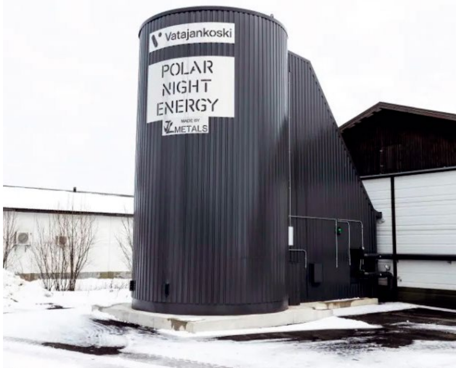
1 pav. Pirmoji komercinė smėlio pagrindu veikianti šilumos saugykla Vatajankoskio elektrinėje (Suomija). Šaltinis: Sand Batteries provide heat to district heating networks in Finland | Solarthermalworld.
