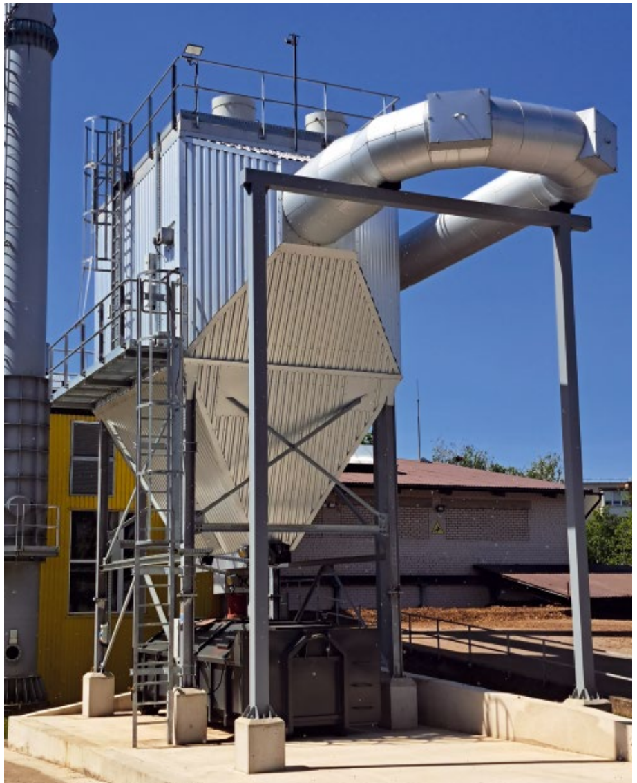
Kelmėje įdiegtas elektrostatinis filtras
