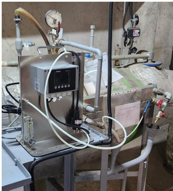
3 pav. Deguonies koncentracijos tinklo vandenyje matavimo prietaisas.
