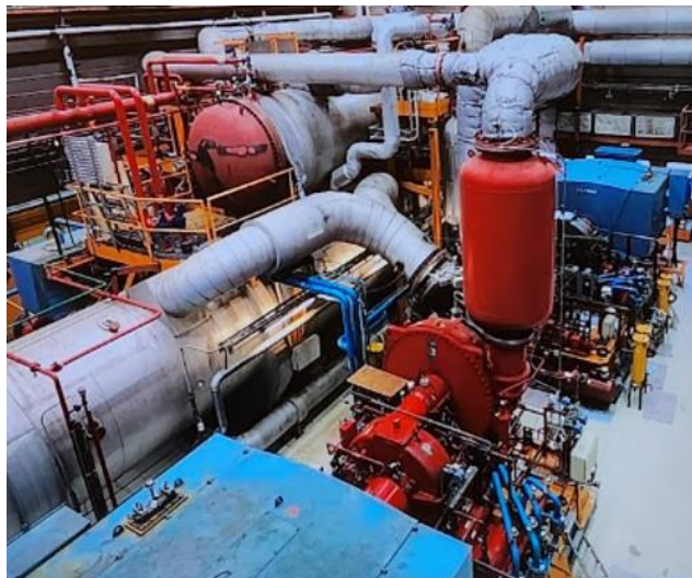
2 pav. Dviejų ir trijų pakopų kompresoriai
