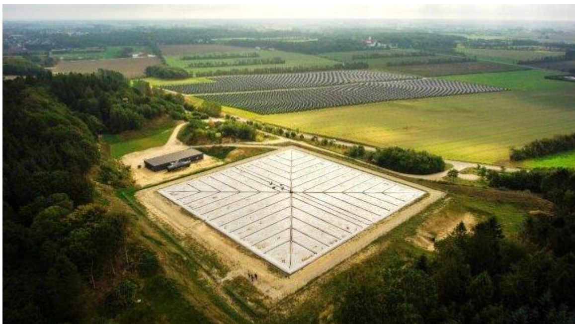
Šilumos saugykla Danijoje, Dronninglund Fjernvarme ( www.solarthermalworld.org nuotr.)
