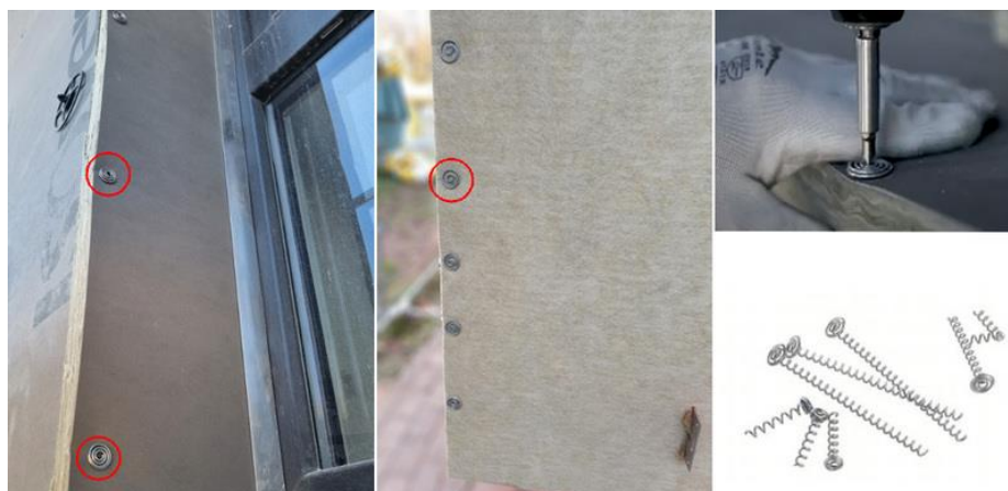
5 pav. Priešvėjinių plokščių kampinių jungčių tvirtinimas spiraliniais sraigtais.
