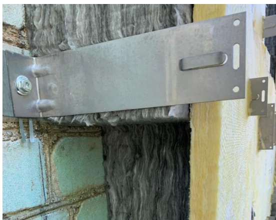
2 pav. Vėdinamo fasado karkaso elementas – nerūdijančio plieno konsolė.
