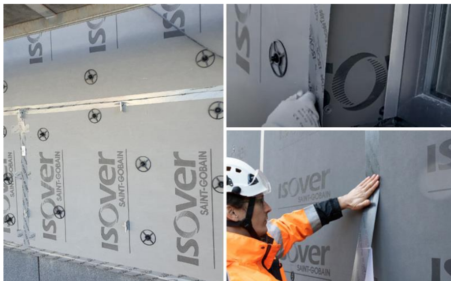
4 pav. ISOVER Facade siūlų sandarinimas.
