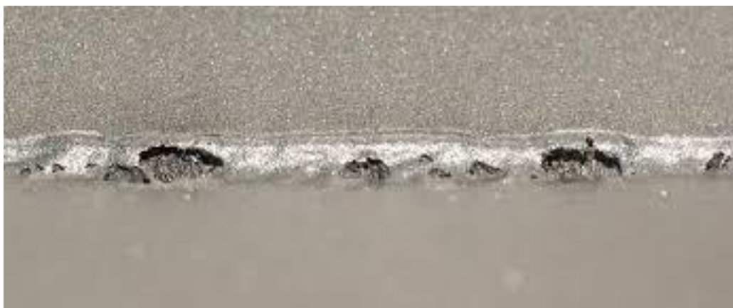
4 pav. Plyšinė korozija.
