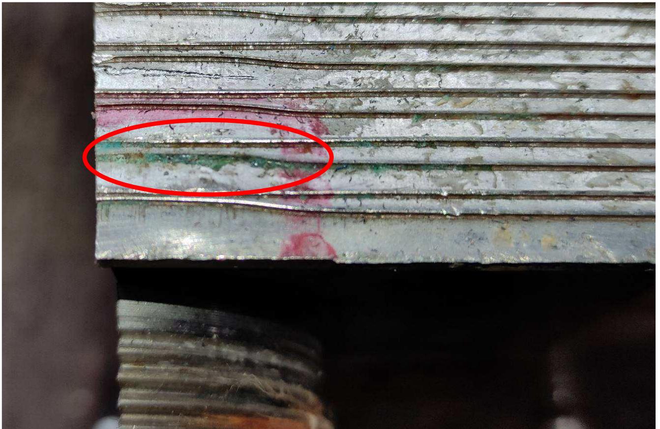
5 pav. Nesandarumo vieta. Vario korozija.
