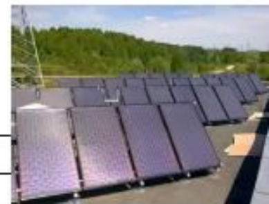
Saulės kolektorių sistema (114 m 2 ) Kruonio HAE karštam vandeniui ruošti (~5,0m 3 /parai)
