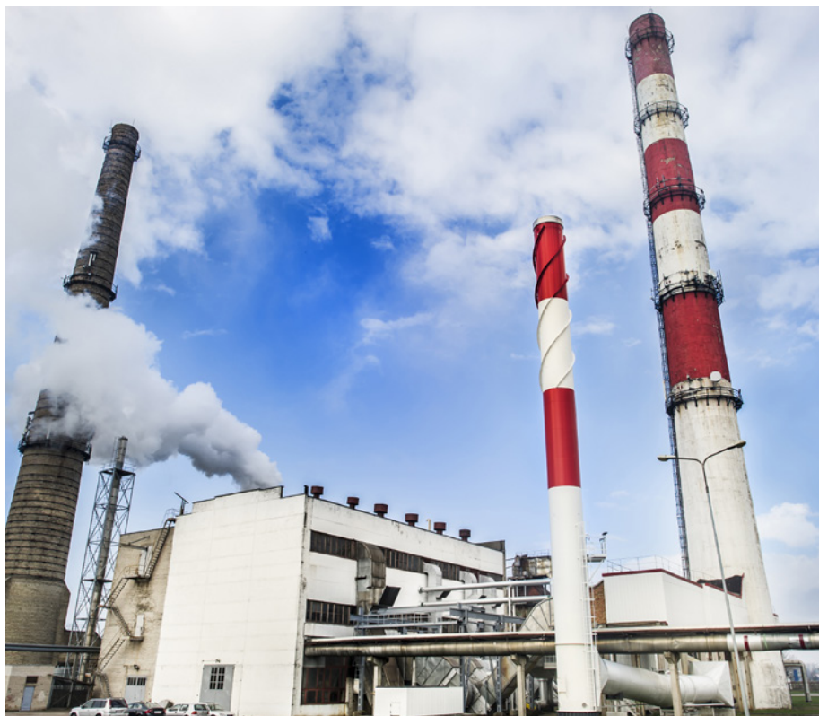
Klaipėdos energijos termofikacinė elektrinė
