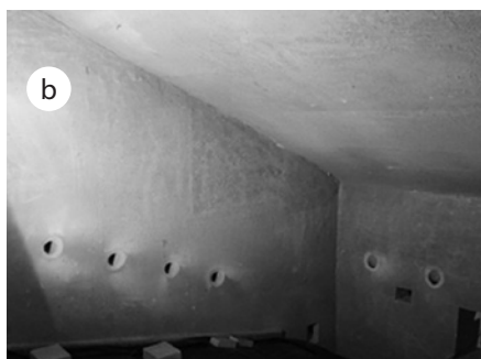
1 pav. Biokuro katilo pakuros iškloja: a – pagaminta iš šamotinių plytų, b – iš ugniai atsparaus betono
