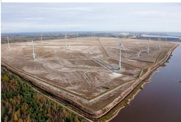
Ветропарк мощностью 39 МВт на золоотвале
