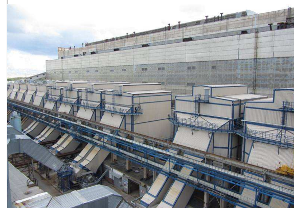
Оборудование сероочистки (deSOx)
