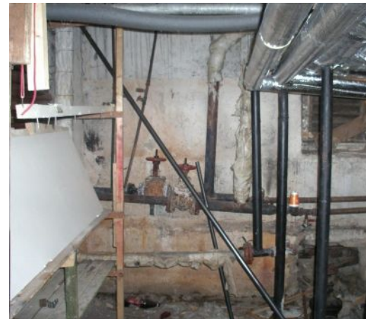
3 pav. Senas neprižiūrimas daugiabutis ir jo vidaus šildymo ir karšto vandens sistemos dalies būklė
