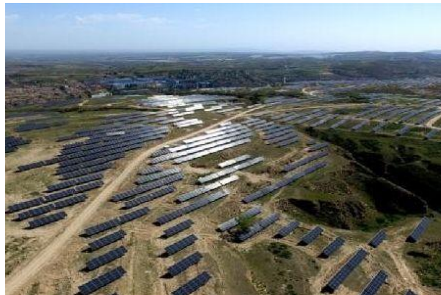
1000 MW Datongo saulės elektrinė, Kinija
